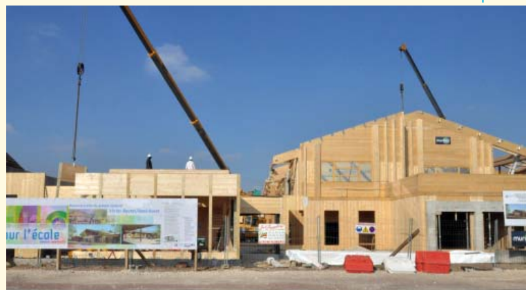
La construction du groupe scolaire du Bourg, principal investissement de la Ville, avance à grand pas.
