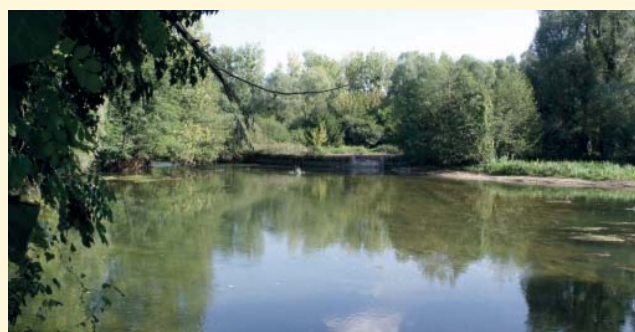
Effacement du Barrage de la Vallée (Girolles/Fontenay/Cepoy) : situation avant et après
