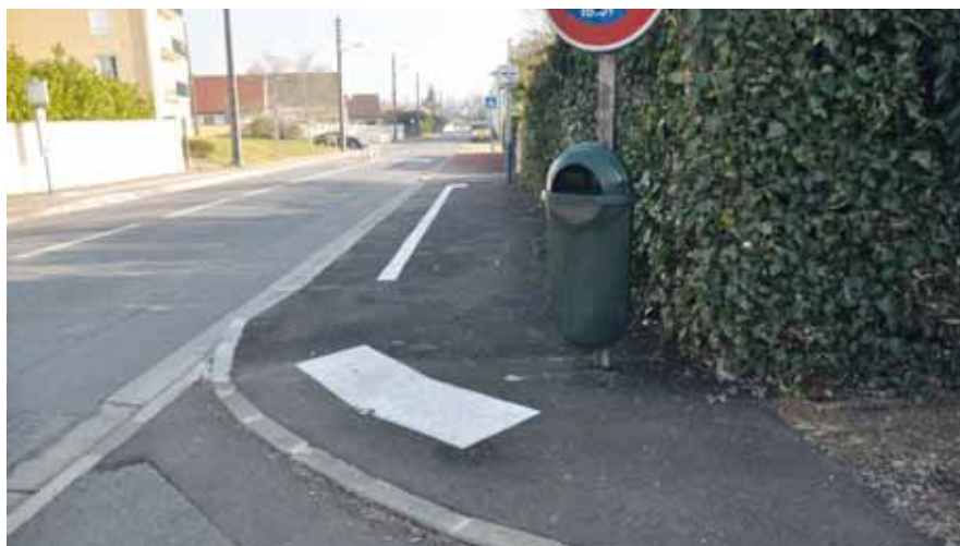
Travaux d'accessibilité : ici, abaissement de trottoirs rue de Villemendeur, près de la Maison de quartier de la Pontonnerie
