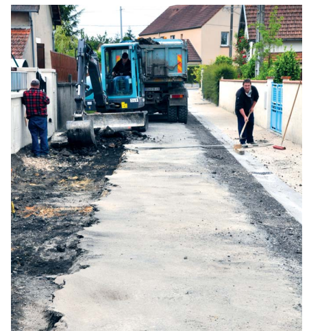
Le chantier rue Laplace
