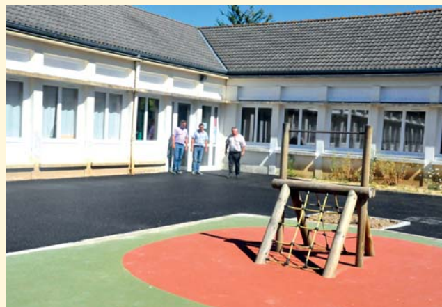
Rénovation de la cour de l'école maternelle de la Pontonnerie
