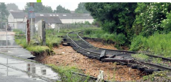
La voie ferrée détruite par les inondations de juin 2016
