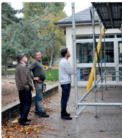
Jacques Lalot, conseiller municipal délégué aux travaux, sur le chantier de l'école G.-Cosson
